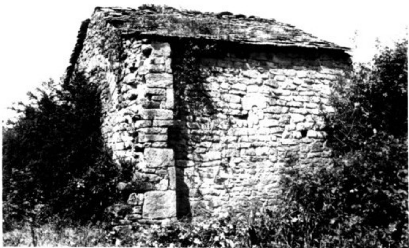
Saint-Etienne du Causse. Elévation méridionale du chœur et vestiges de la nef.
